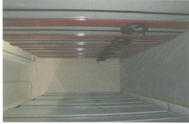
Vedute parziali del deposito archivistico del primo piano
