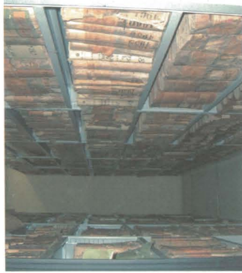
Veduta parziale del deposito archivistico del primo piano
